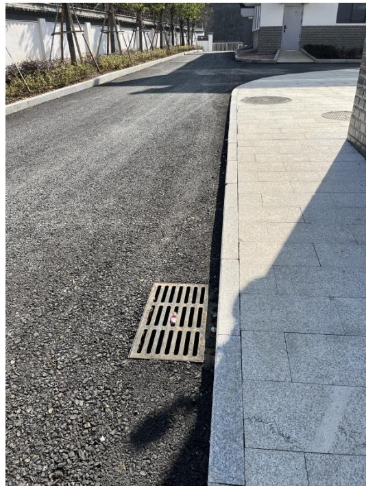
图 4-2 建筑物旁的雨水篦子
